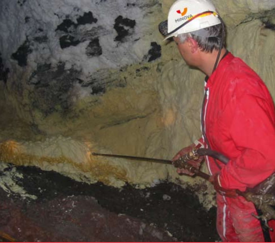
Hohlraumverfüllung (Salines de l'Est, Frankreich)
